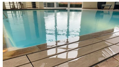
Steinüberdeckung (4 Durchlässe) (Überlaufwehr aus GFK)
