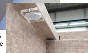
Scheinwerfer in der Rollladen- Auflagekante
